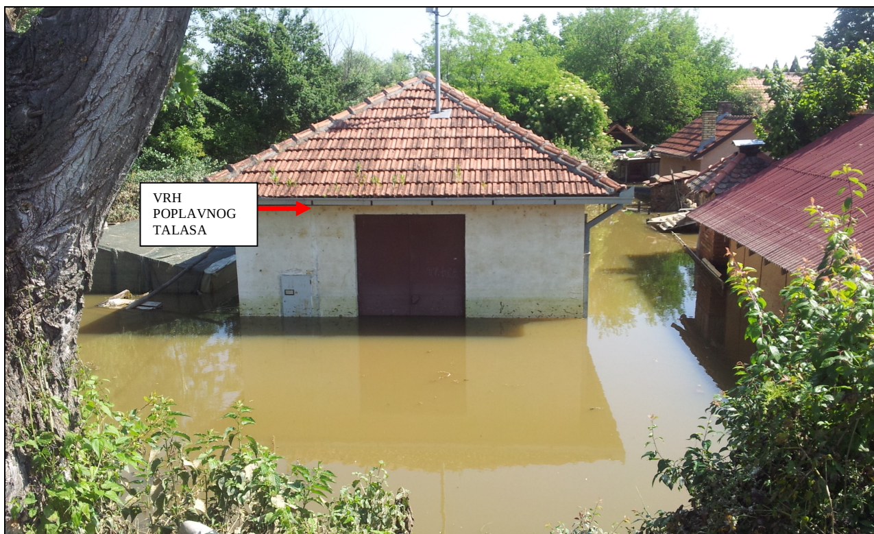
Slika 3. – Toplotna podstanica TP-46A
