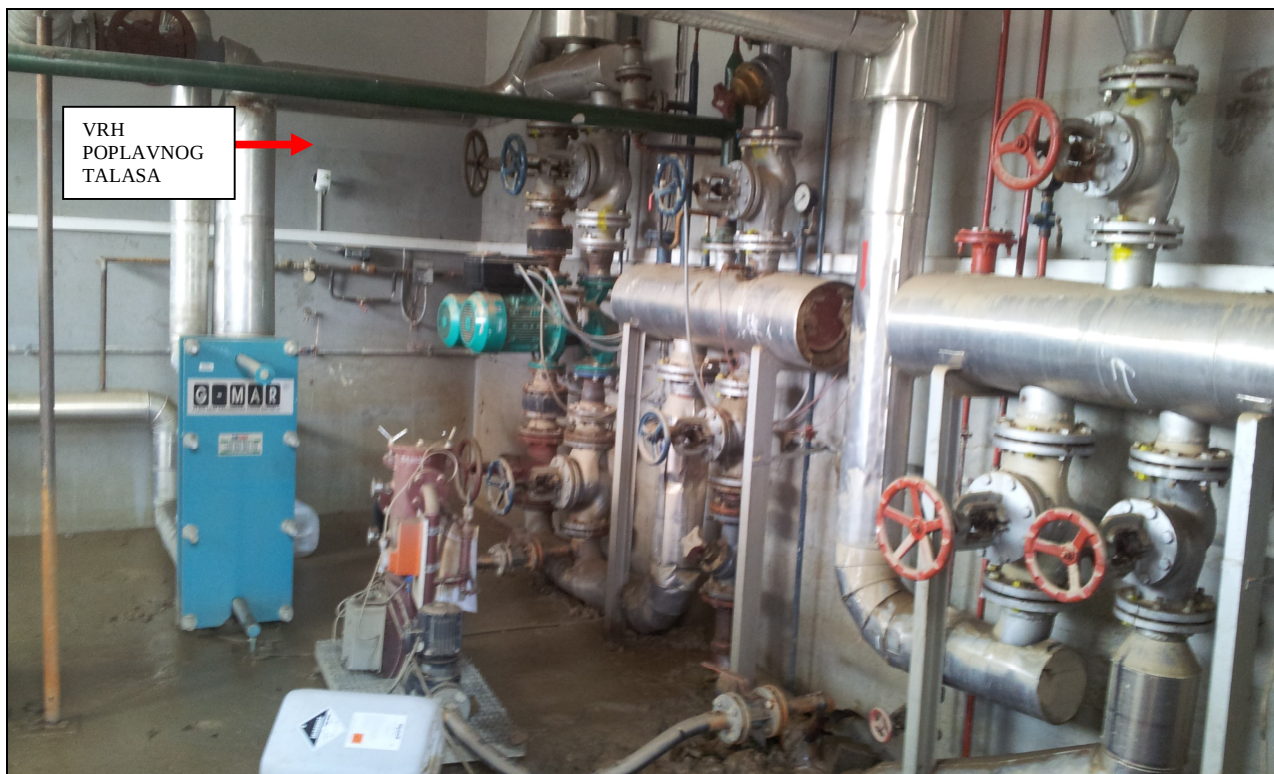
Slika 5. – Toplotna podstanica TP37
